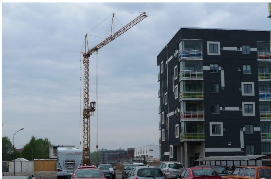
Figur 14. Bild av byggnation av flerfamiljshus. Foto: Pernilla Bylund
