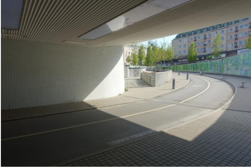
Genom en vidvinkling av tunneln skapas en bättre siktlinje vad som väntar vid tunnelns slut. Foto: Boverket/Kerstin Andersson
