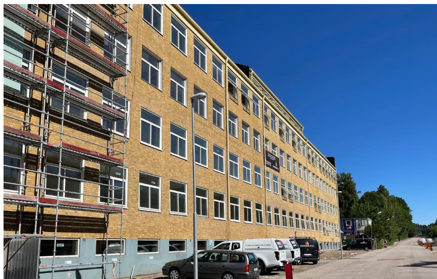
Figur 30. Fasaden på den före detta konfektionsfabriken. Foto: Linn Greaker/Bostäder i Borås.
