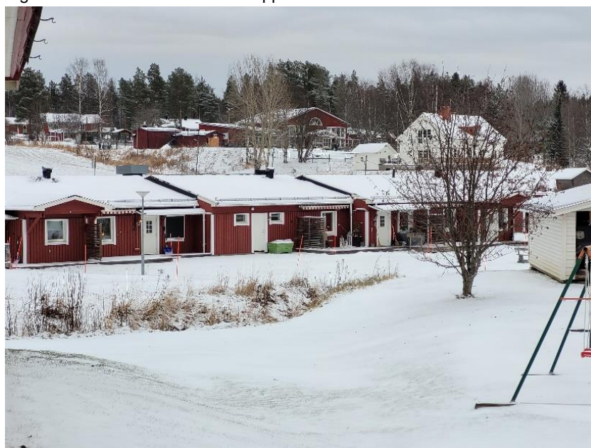
Figur 32. Den omvandlade huskroppen. Foto: Maria Teder/Boverket.
