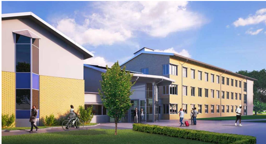
Figur 28. Entré och exteriör efter omvandlingen. Illustration: Vidingehem.
